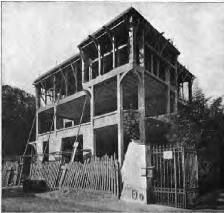
Abb. 27. Rohbau des Hauses in Passy.
